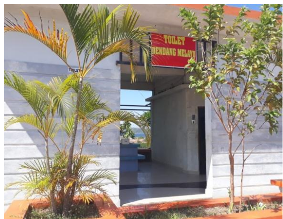
Gambar 4.3 Toilet Dendang Melayu
