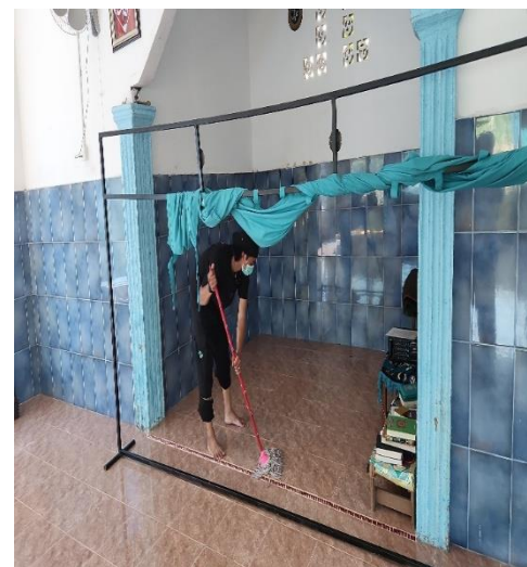
Gambar 3. Kegiatan Renovasi Toilet dan Pembersihan Mushola
