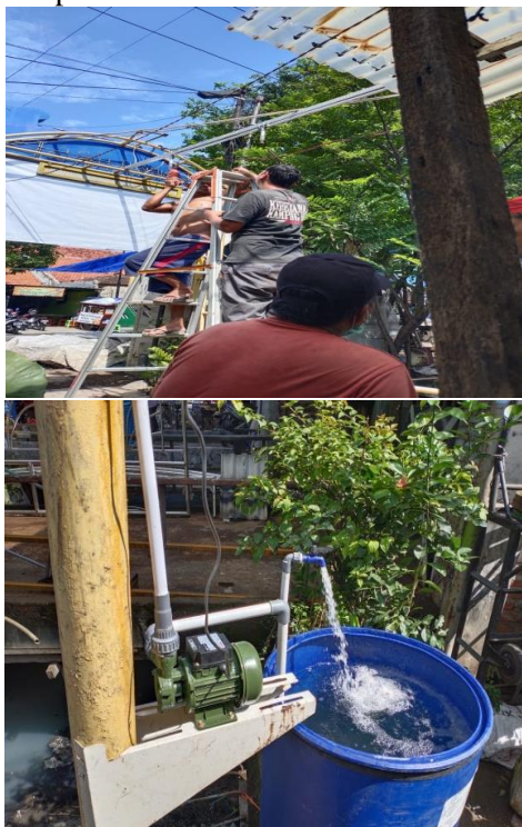
Gambar 5. Pembangunan Rangkaian Sprinkle Spray Desinfektan
