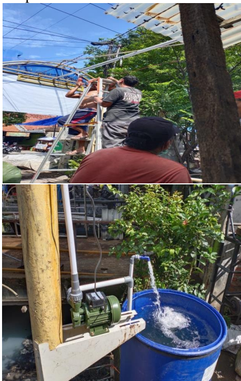
Gambar 5. Pembangunan Rangkaian Sprinkle Spray Desinfektan
